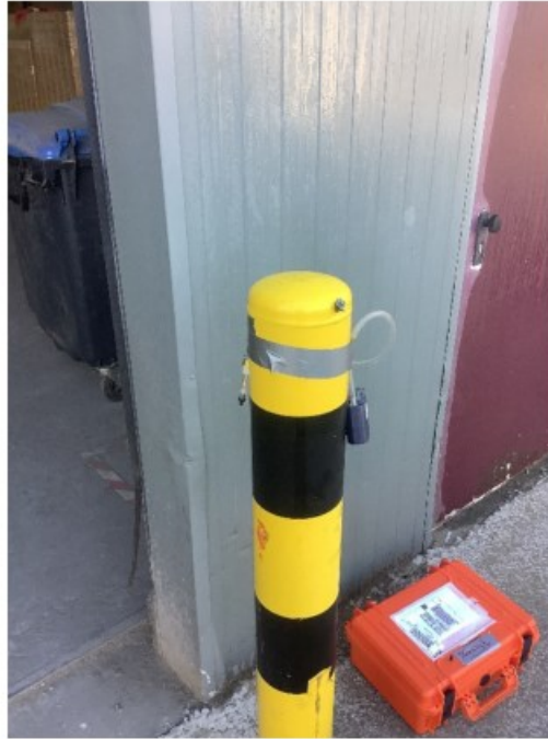
Pomp 1 bovenzijde droogschuur
