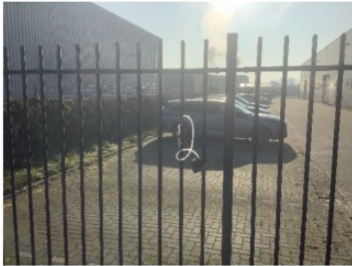
Pomp 4 aan hek achterzijde
