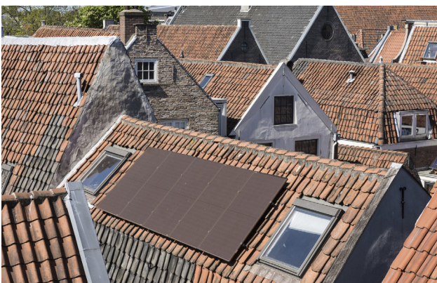
Zorgvuldige verduurzaming beschermd stadsgezicht (energie besparen, uit het zicht plaatsen, zorgvuldige kleurkeuze panelen)
