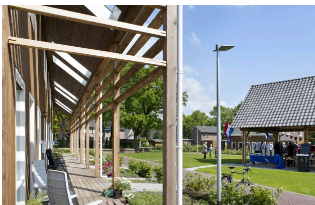
Vernieuwing bestaande woningen met o.a. veranda's als tussenzone voor ontmoetingsaanleidingen. (DAAD architecten)
