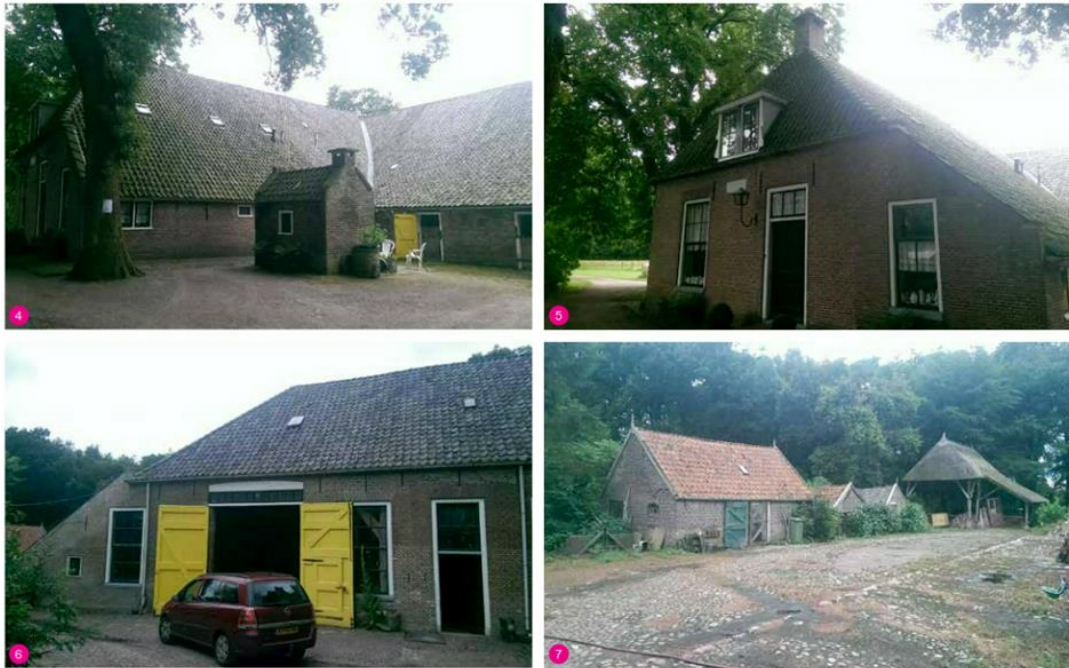
Afbeelding 2.2 Foto's bestaande situatie (Bron: B+O Architectuur en interieur B.V.)
