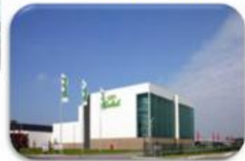
Bedrijf (bv. ammoniakkoelinstallatie)
