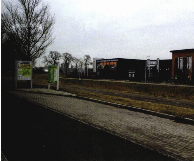
Bewegwijzering is uniform en aanleg parkeerhaven
