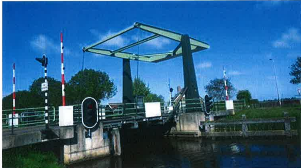
Figuur 4 Beweegbare brug (automatisch) Halfwegdiep
