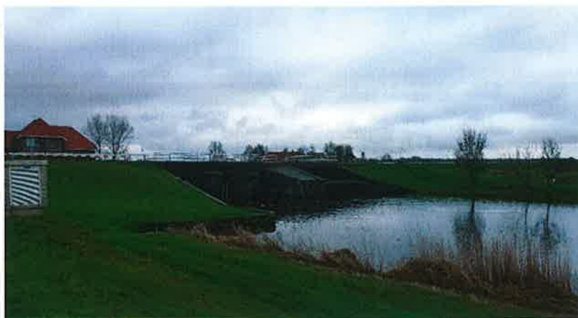
Figuur 6 Brug nabij gemaal Stroink
