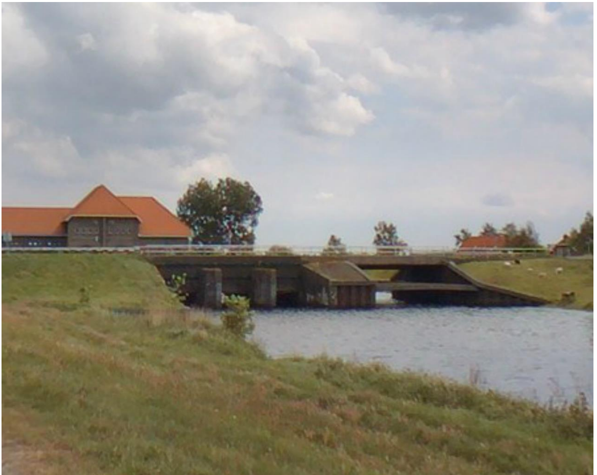
Foto: huidige brug bij Stoinkemaal
